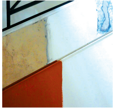
Sondages pour la réhabilitation de la rotonde en 2009
